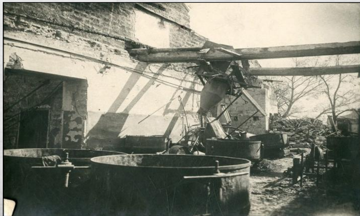
Ставропольский хлебокомбинат, разрушенный в период оккупации. 20 марта 1943 года.
