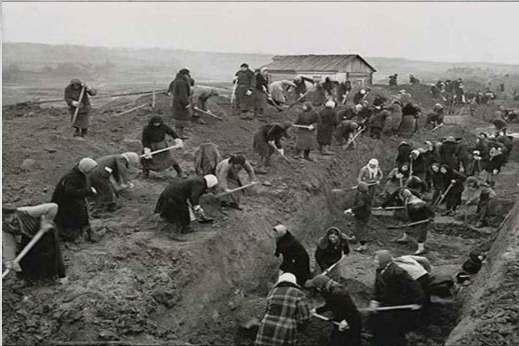
Жители города Ворошиловска (Ставрополя) на строительстве противотанкового оборонительного рва. Декабрь 1941 года.
